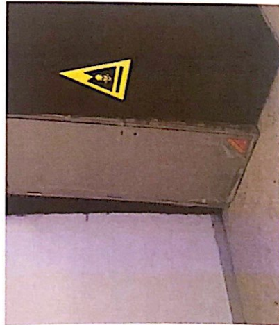
废机油暂存间
