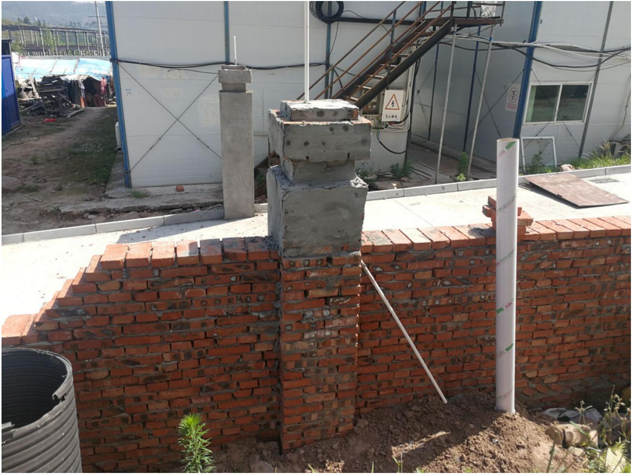
化粪池导气孔
