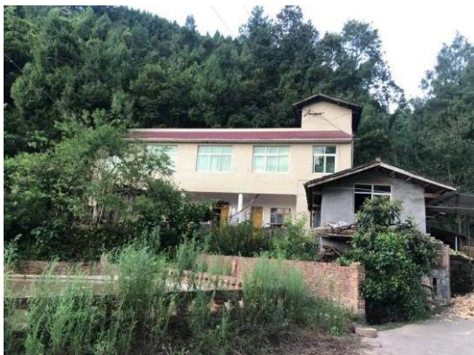
巴中牵变所所址中心测点现场照片
