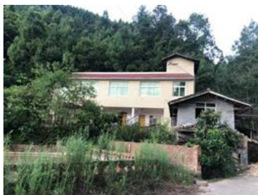
巴中牵变电所
