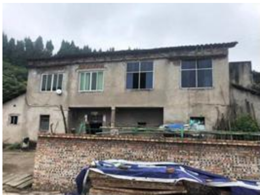
南充北牵变电所
