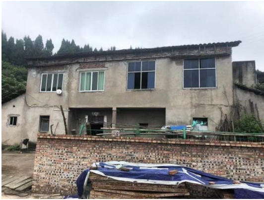
南充北牵变所所址中心测点现场照片
