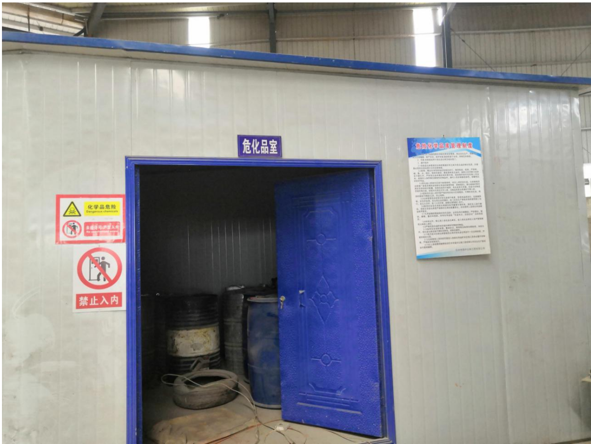
危废暂存间和危化品室
