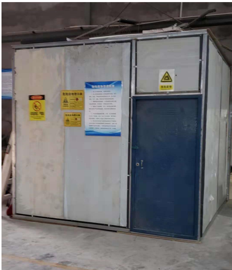
照片 3-1 危险废物暂存间
