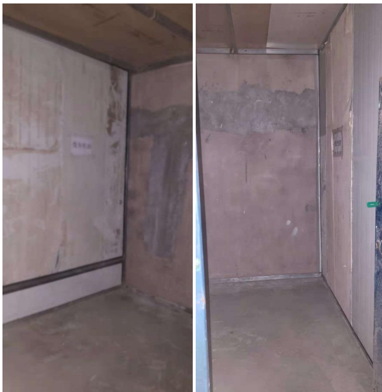
照片 3-2 危险废物暂存间内部
