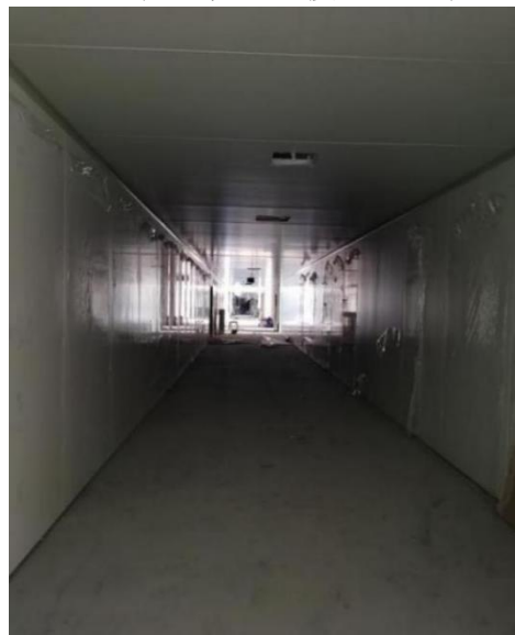
DSA手术室拟建址西北侧污物通道
