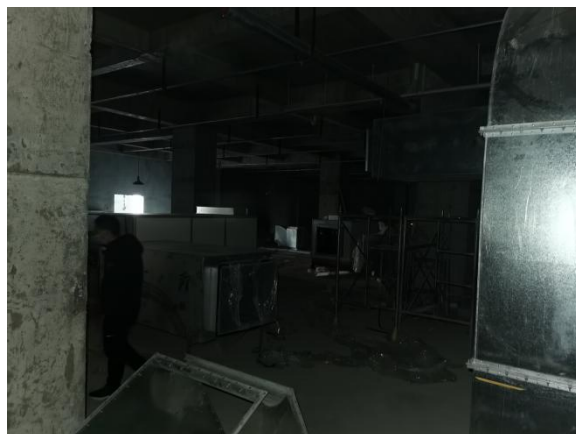
DSA手术室拟建址楼上空调机房
