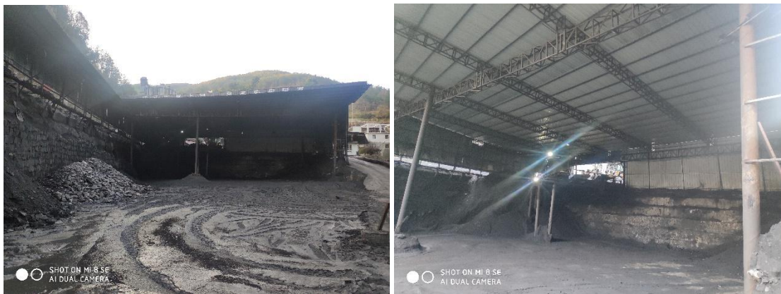
堆煤场现状照片
